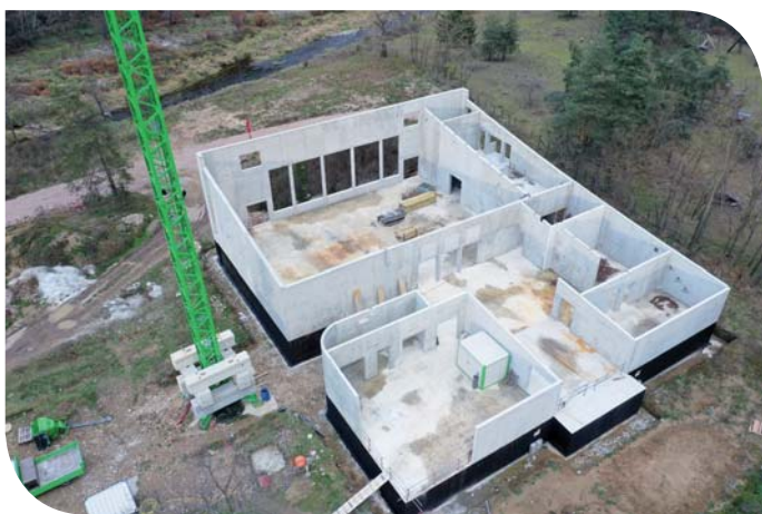
Vue aérienne de la future salle polyvalente
