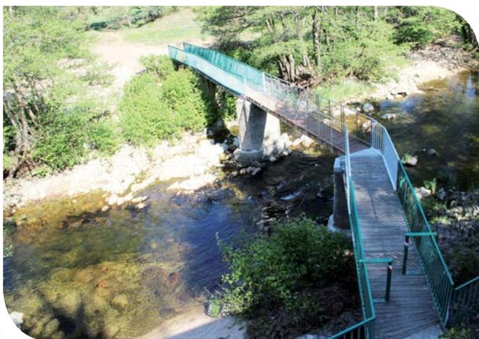
La partie centrale du pont est en acier galvanisé et le sol est en bois antidérapant. Les barreaux des garde-corps ont été resserrés afin d'en optimiser la sécurité.
