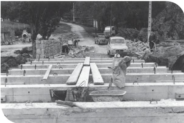
*Des dalles et des poutres ont été installées pour le tablier du pont*
